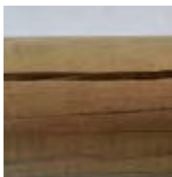
Cracks/Grietas/Fente/Risse/ Crepe/ Barsten/Fendas
