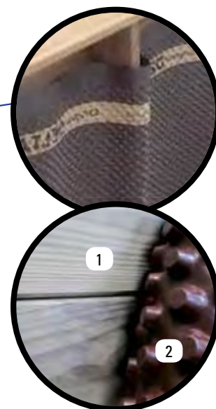
1- Ossature bois 2- Rouleau de protection et de drainage alvéolaire en PEHD
